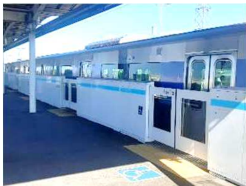
更新した可動式ホーム柵
